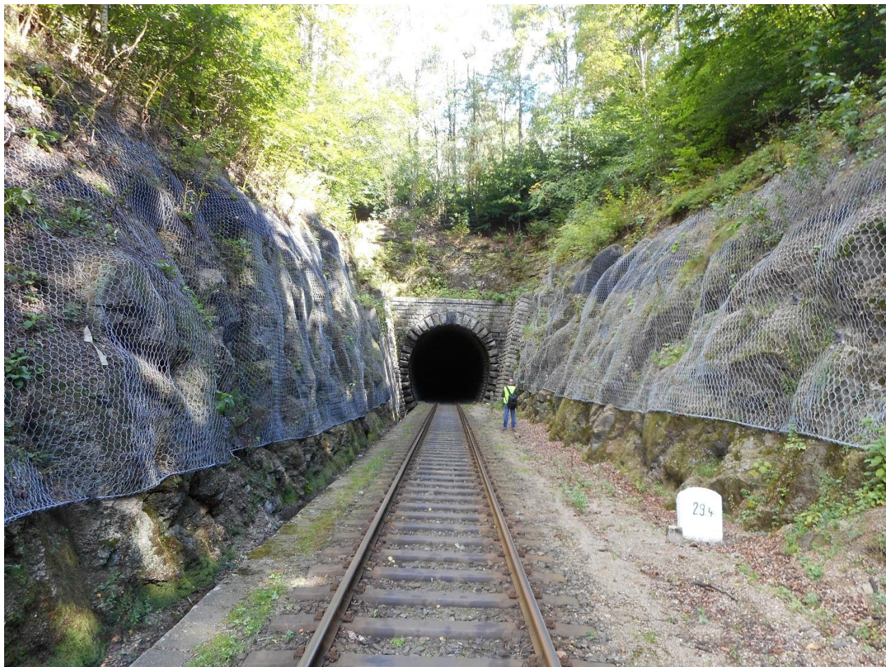
Obr. č.2: Kamenný rigol před Desenským tunelem v km 29,400 – pohled po směru staničení
