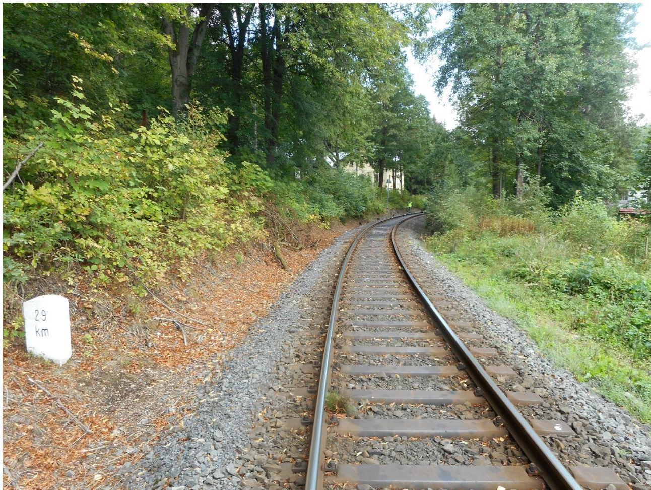
Obr. č.1: Začátek úseku, zanesené příkopy – pohled po směru staničení
